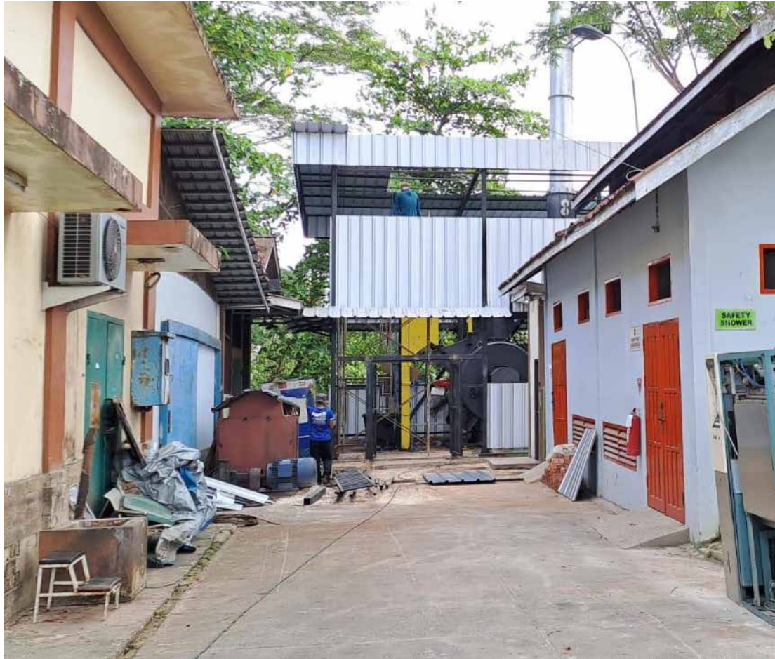
Proses pengerjaan incenerator baru milik RSUD Bontang di instalasi kesehatan lingkungan. (Yahya Yabo)
