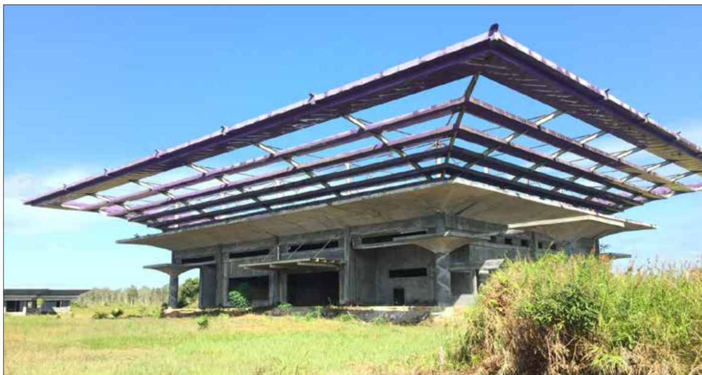
Kondisi pembangunan bandara
